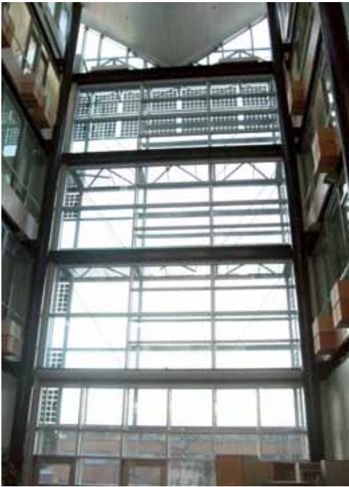
Foto 20. ↓ Siseõuedes ei ole jahutust ja ülekuumenemist välditakse, avades all ja üleval olevaid ajamitega aknaid.
