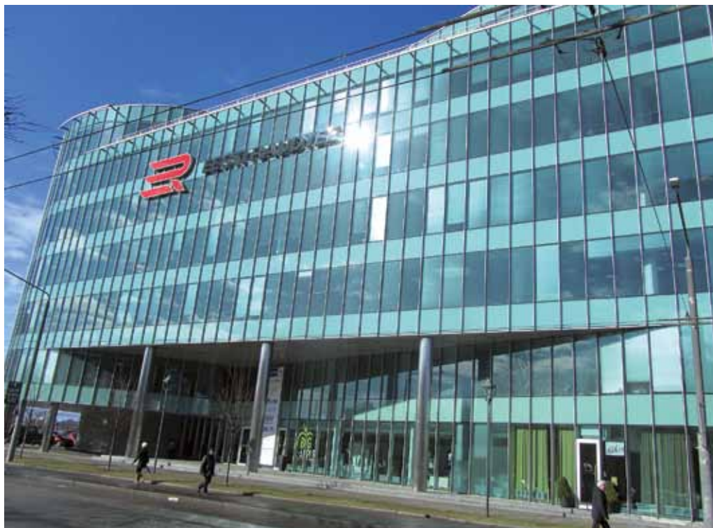
Foto 15. ↓ Eesti Raudtee büroohoone Balti jaamas Tallinnas. Fassaadi päikesekaitse on lahendamata. Sisemised ribikardinad on peaaegu püsivalt suletud asendis.
