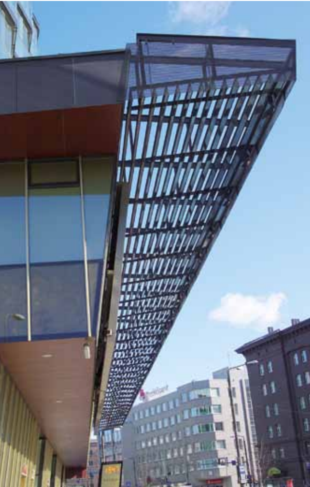
Foto 6. ↑ Foorumi kaubamaja Tallinnas. Isevarjestuva fassaadi kombinatsioon kaldseinast ja fassaadi välisvarjestusest.
