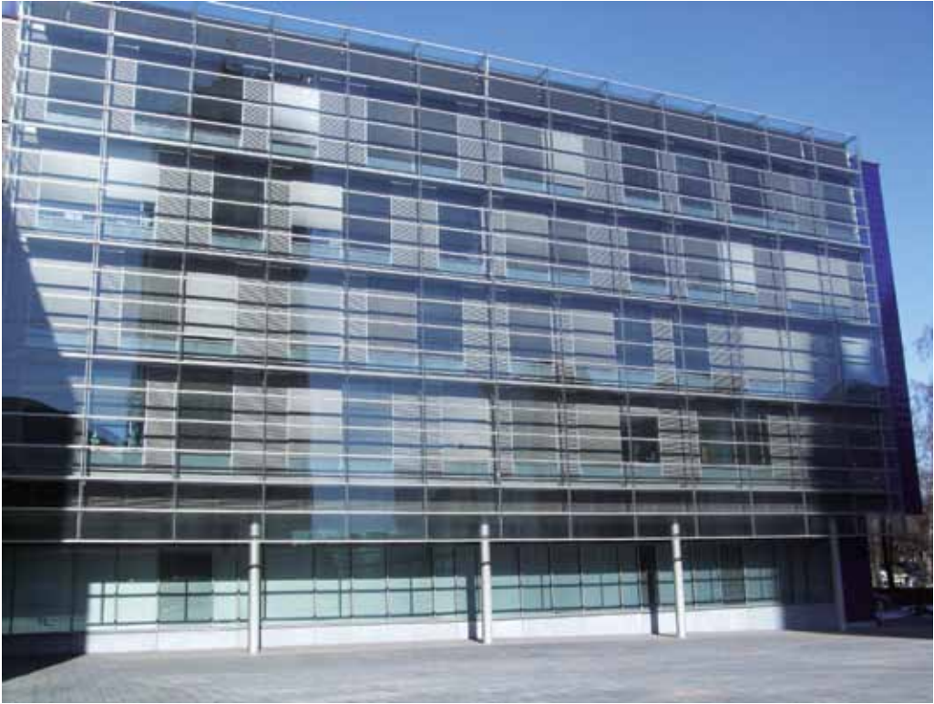
Foto 13. ↓ Ilmarinen, Porkkalankatu 1 Helsingi. Topelfassaad vaheplatvormidega, ribikardinad topelfassaadi vahel.
