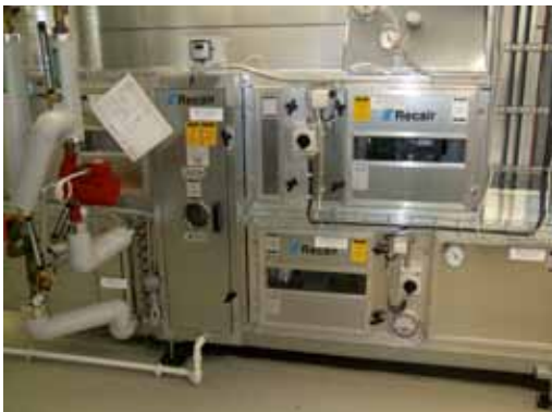
Foto 22. ↑ WC-grupi rootorsoojusvahetiga ventilatsiooniseade.
