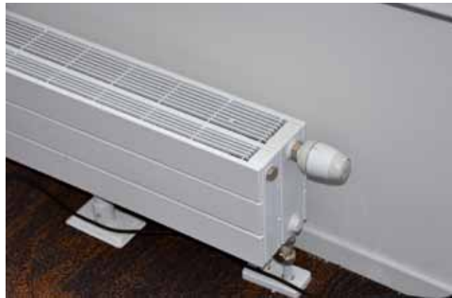
Foto 2. ➤ Ruumitemperatuuri regulaator jahutusele ja kütteradiaatori termostaat.
