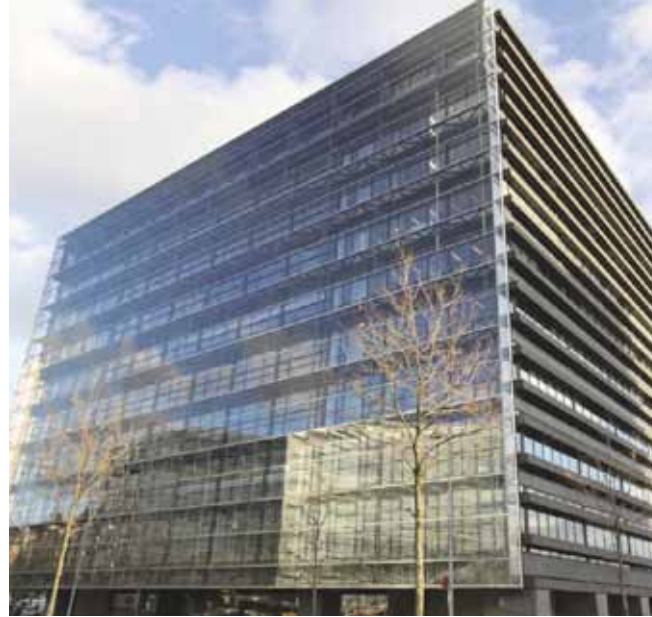
Foto 8. → Kontorihoonet Taanis Kopenhaagenis. Lõunafassaadi lahendusena on kasutatud arhitektuurilisi elemente ja lääne suunas topelfassaadi.
