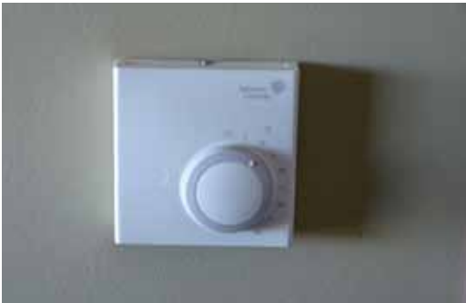
Foto 2. ➤ Ruumitemperatuuri regulaator jahutusele ja kütteradiaatori termostaat.
