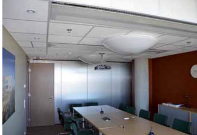
Foto 1. ➤ Näide büroomaastiku lõppseadmete paigutusest ripplagedeta ruumis ja ripplaega nõupidamisruumis.
