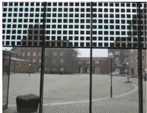
Foto 17. ↓ Näiteid klaas- või topelfassaadi integreeritud PV-paneelidest.
