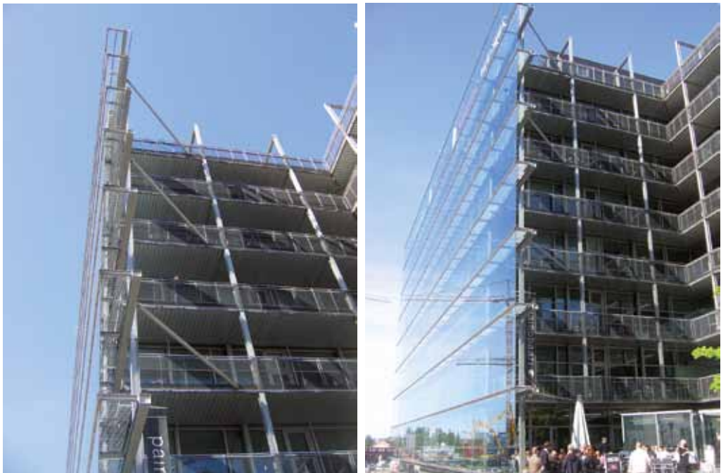
Foto 14. ↑ Sanomatalo, Töölönlahdenkatu 2, Helsingi. Topelfassaad vaheplatvormidega, ribikardinad topelfassaadi vahel.
