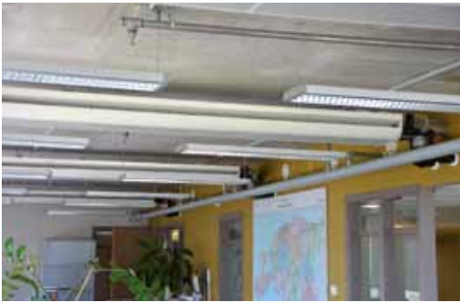
Foto 1. ➤ Näide büroomaastiku lõppseadmete paigutusest ripplagedeta ruumis ja ripplaega nõupidamisruumis.
